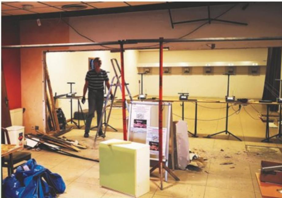
Die zwischen Gastraum und Schießstand im Vereinsheim stehende Wand wurde erfolgreich entfernt. Dank moderner Technologie wurde die Wand durch ein neues Glasschiebetürensystem ersetzt, das dem Innenraum einen neuen, modernen Anblick verleiht. Durch den Abriss dieser Zwischenwand wirkt der Raum nun
